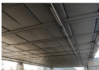
Anti-corrosiebehandeling van kolom en bodemplaten
