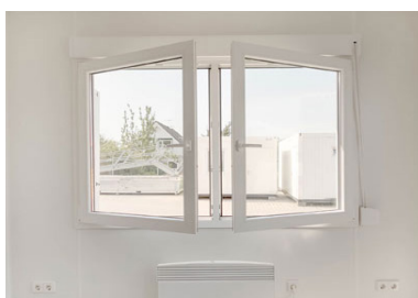
Goede isolatie en ventilatie
