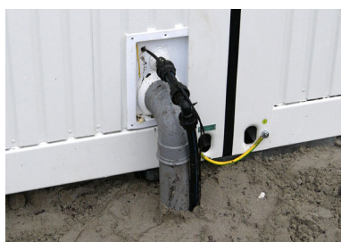
Nuts dmv CEE-stekker en tyleen aansluiting
